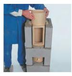
Priključak za vratanca okrenite i stavite u plašt dimnjaka. Spoljna ivica spoja dimne cevi okrenuta je nagore. Nastavak za vratanca mora biti paralelan sa plaštem dimnjaka.
