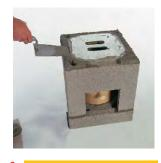
Prilikom nanošenja maltera koristite šablon za malterisanje, koji sprečava padanje maltera u plašt i cev dimnjaka.
