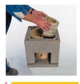
Ubacite tervol ploče. Ploče mogu da se dodiruju samo na sredini stranice plašta dimnjaka.
