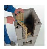
Namestite isečen plašt dimnjaka. Ubacite izolaciju i isecite ispred ventilacionog kanala.
