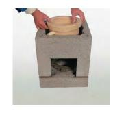
Na izolovano betonsko postolje nanesite sloj maltera i postavite isečen plašt dimnjaka. Podmetač sa ispustom kondenza ubacite u sredinu plašta dimnjaka.
